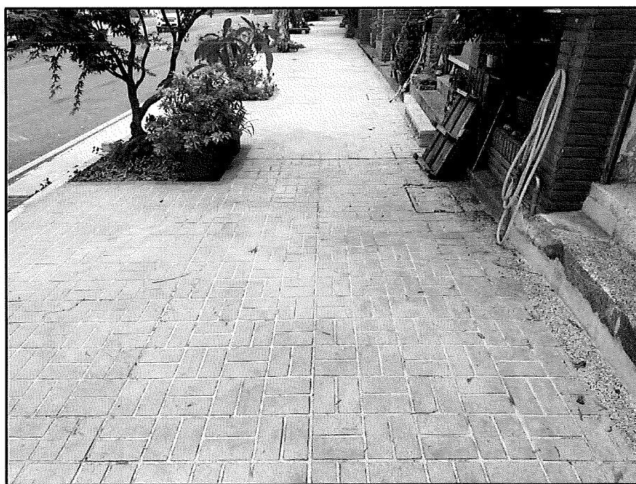
圖一，濕式紙模地坪(灰色、網織型)示意圖。
