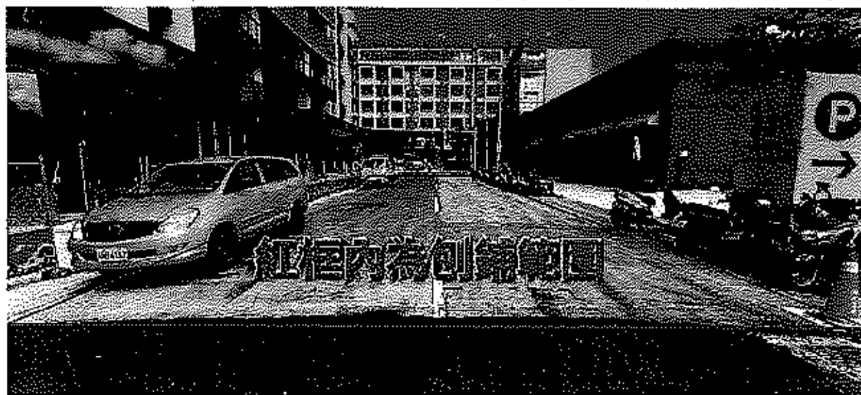
上圖為 40 米興林二街主線(施工期間採一半道路封閉；一半開放通行施工方式。)
